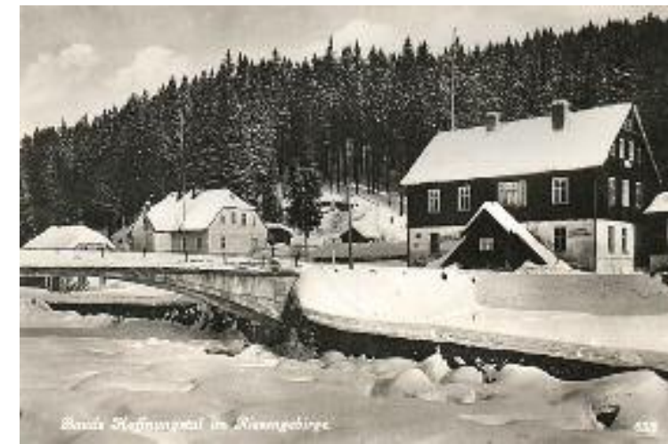
Železobetonový most v Údolí Naděje. (Kopie, sbírka P. Kurtina)
