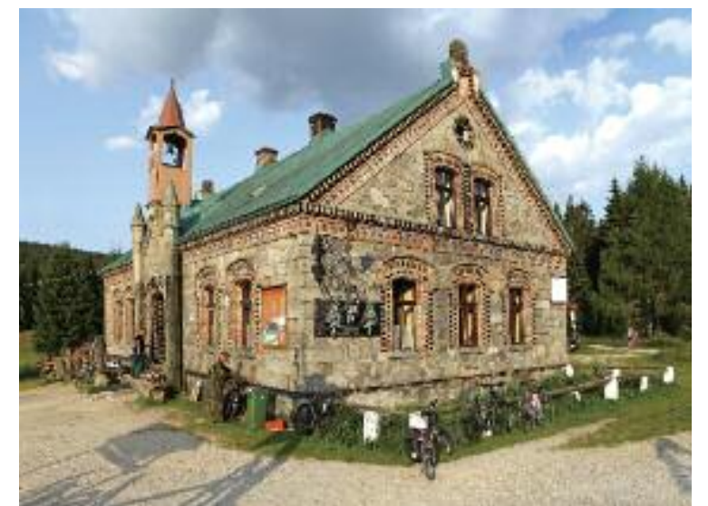
Hlavní budova turistické stanice v Orle. (24. 7. 2021, foto R. Karpaš)
