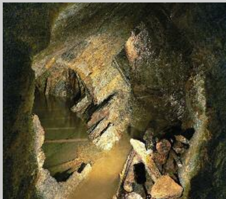
ŠTOLA DĚTI IZRAELE (11. 12. 2002, iro) Na prvním snímku komora nad zatopeným hloubením (vlevo) a odvodňující štola (vpravo). Na druhém pohled od vchodu na spojení hlavní a odvodňovací štolky.
