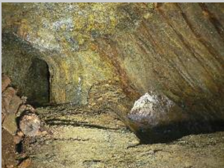
ŠTOLA DĚTI IZRAELE (11. 12. 2002, iro) Na prvním snímku komora nad zatopeným hloubením (vlevo) a odvodňující štola (vpravo). Na druhém pohled od vchodu na spojení hlavní a odvodňovací štolky.
