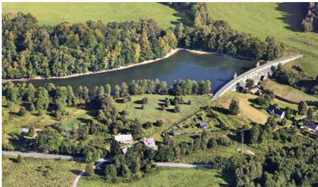
CELKOVÝ POHLED NA PŘEHRADU MLÝNICE OD SEVEROZÁPADU (9. 9. 2009, ata)
