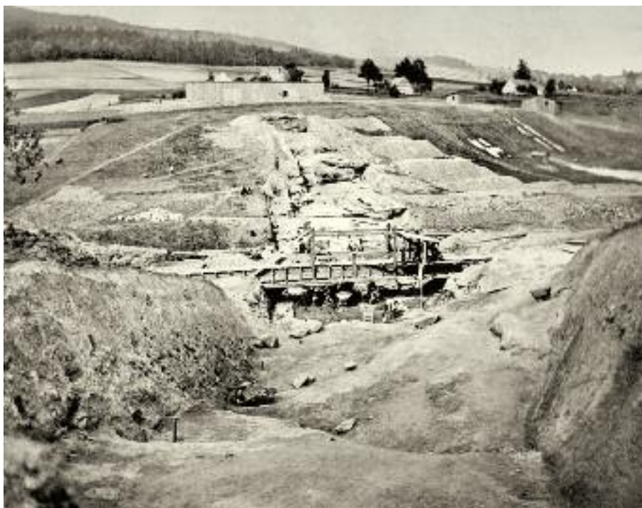
POČÁTEČNÍ PRÁCE NA STAVBĚ HRÁZE PŘEHRADY MLÝNICE (1904, Povodí Labe)
