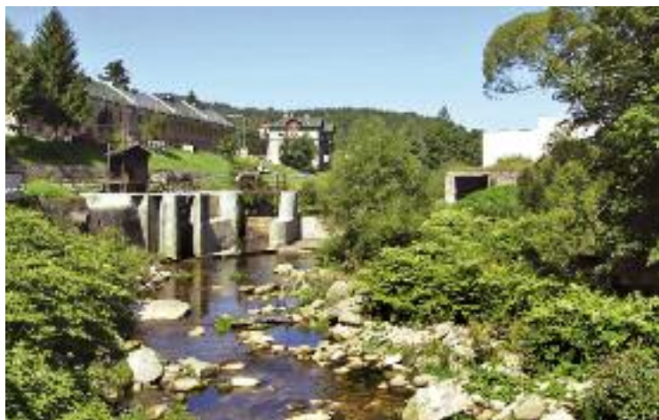
POROSTY KŘÍDLATKY POD JEZEM V TANVALDU (2008, fmr) Jez nad čistíčkou odpadních vod. V této velmi industrializované zóně není zejména na březích Kamenice o křídlatku nouze.
